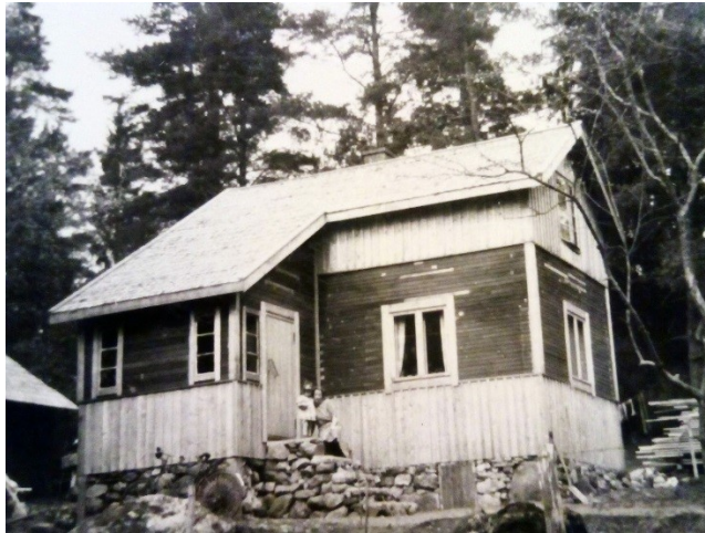
Kuva 4. Tontilla on aiemmin sijainnut puuverhoiltu päärakennus, joka on arviolta 1920-luvulta peräisin.
